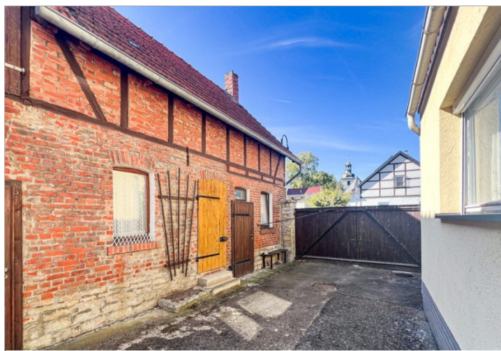
Hofeinfahrt mit Scheune und Wohnhaus
