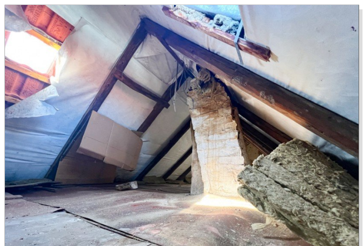
Gedämmter Dachboden Wohnhaus
