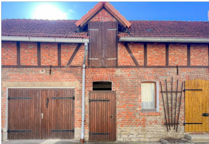
Scheune mit 2 Etagen Ausbaupotential
