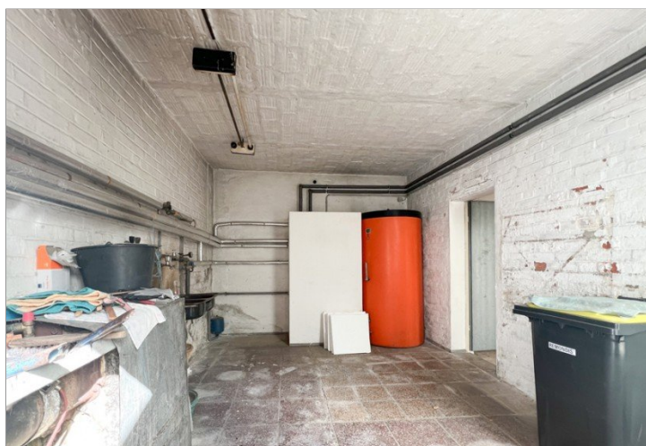
Großer Waschraum im Anbau
