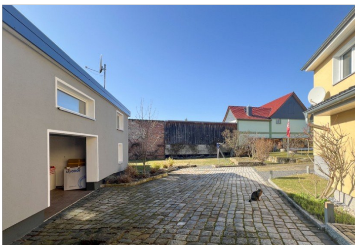
Innenhof zwischen Wohnhaus und Hinterhaus
