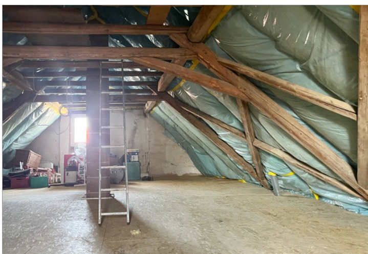
Dachboden mit Ausbaupotential
