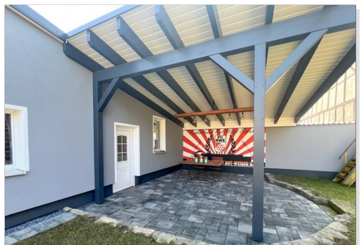
Carpport, der sich als überdachte Terrasse definiert
