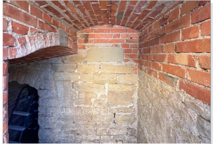
Kellereingang im Hinterhaus
