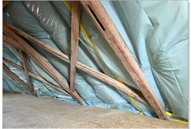
Bereits gedämmter Dachboden
