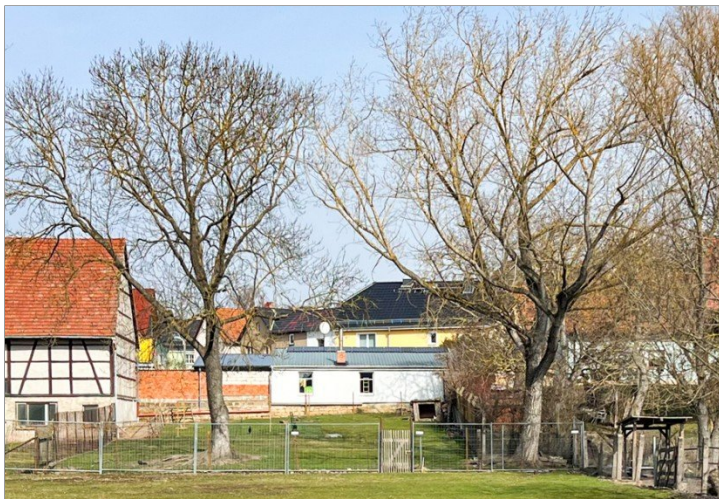
Garagendach mit Photovoltaikanlage
