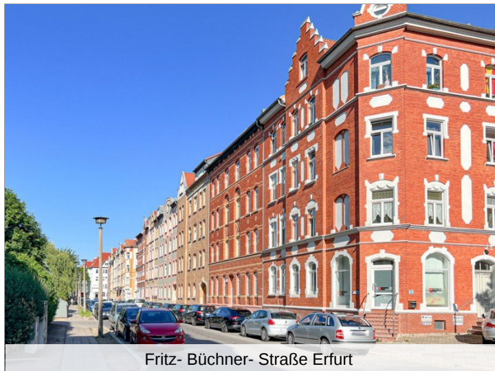
2 Etagenwohnungen im 1.OG
