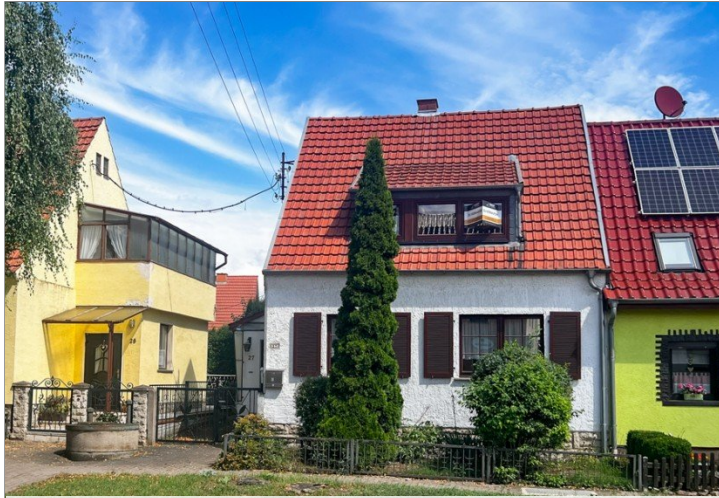
Kleines Einfamilienhaus in Großengottern
