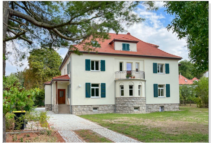
Wohnen im sanierten Altbau
