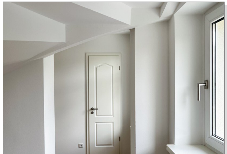
Durchgang zur Speisekammer
