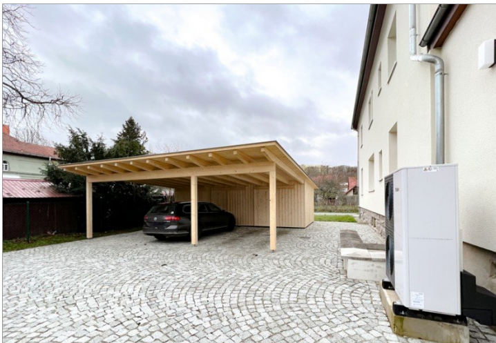
Neu errichteter Carport
