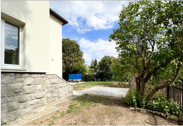
Terrasse mit direktem Wohnungszugang
