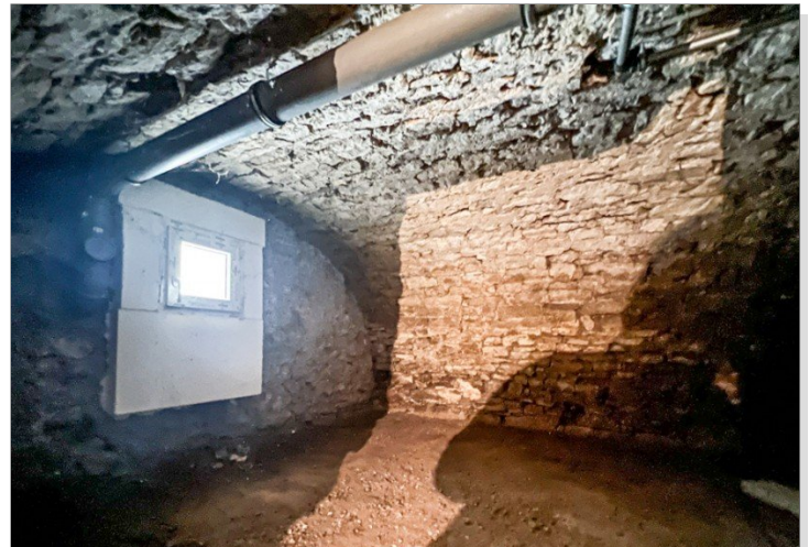
Kleiner Keller unter Wohnhaus
