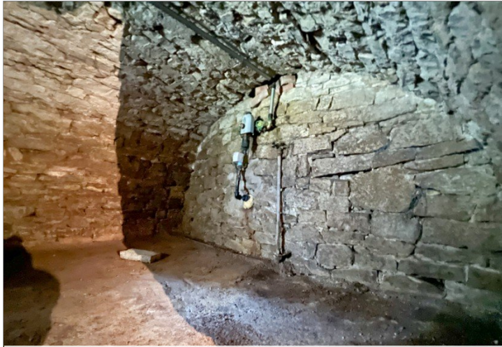
Kleiner historischer Gewölbekeller
