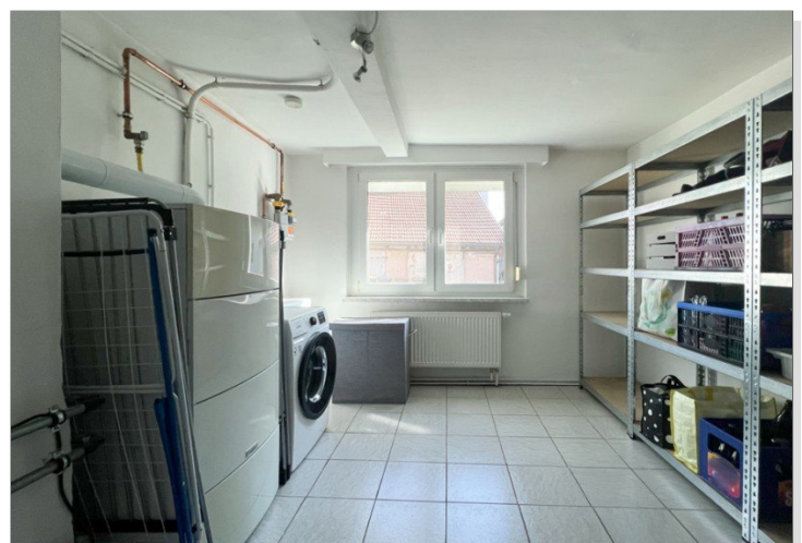
Großer Hauswirtschaftsraum mit Heizung
