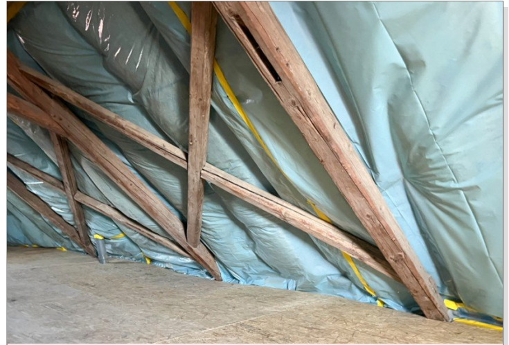
Bereits gedämmter Dachboden
