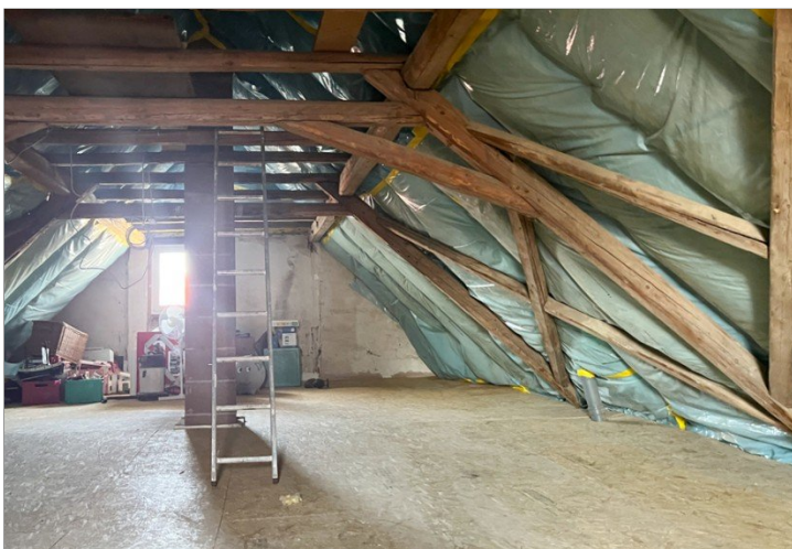
Dachboden mit Ausbaupotential
