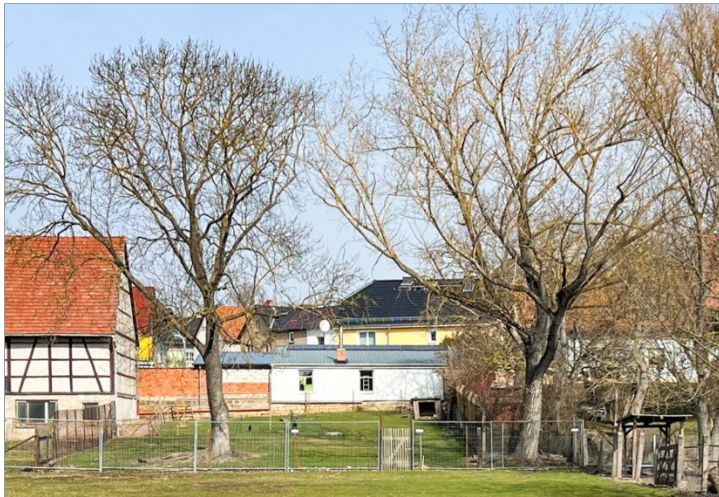
Garagendach mit Photovoltaikanlage
