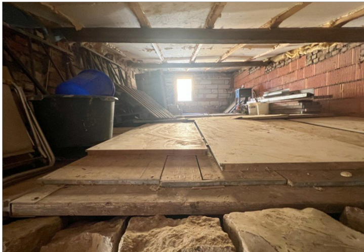
Holzlager über Kellereingang im HH
