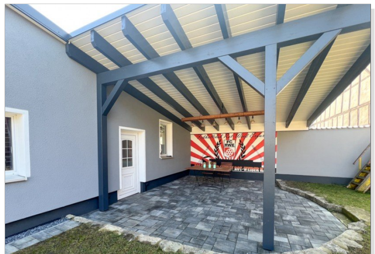
Carport, der sich als überdachte Terrasse definiert
