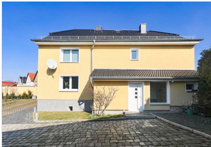
Saniertes Wohnhaus im Erfurter Westen
