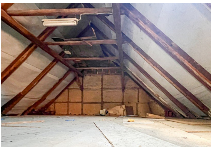
Dachboden mit Ausbaufäche
