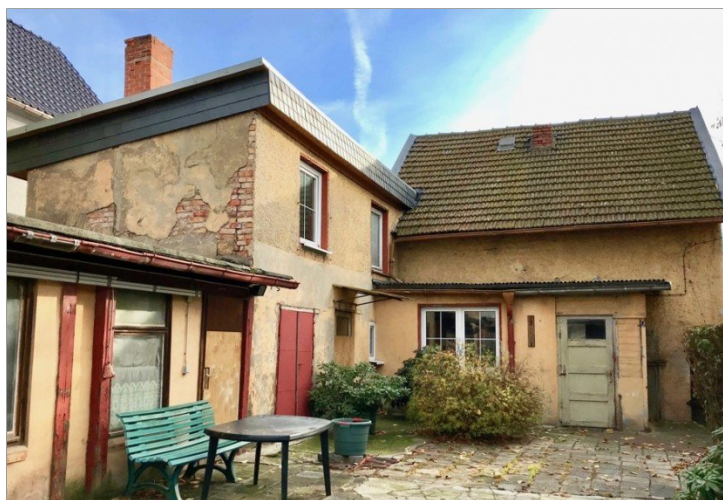
Hofansicht Haupt- und Nebengebäude
