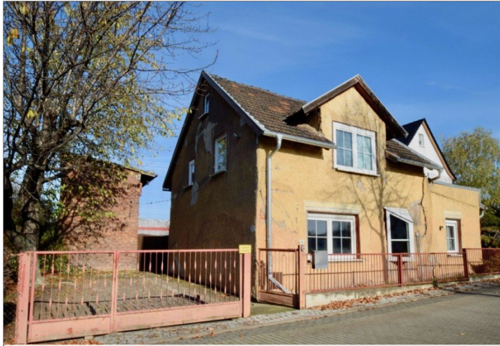
Haus mit Nebengebäude
