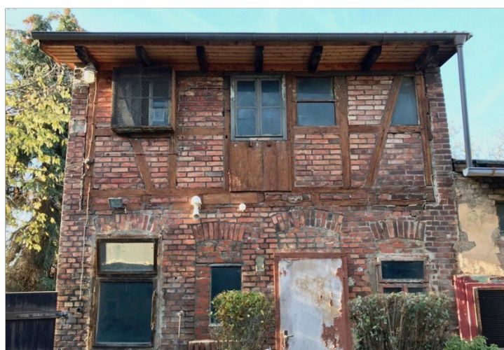
Kleines Backsteingebäude mit Keller
