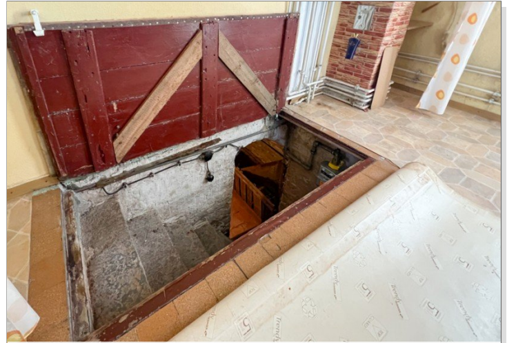
Zugang kleiner Gewölbekeller
