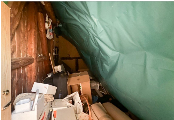
Eine der Dachflächen
