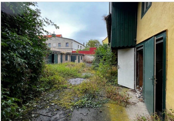
Garagen und Hinterhaus_
