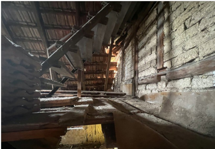
Zuerst das Dach reparieren
