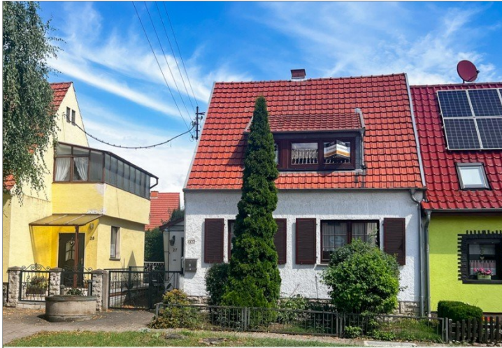
Kleines Einfamilienhaus in Großengottern
