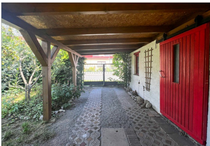
Garport am Grundstücksende
