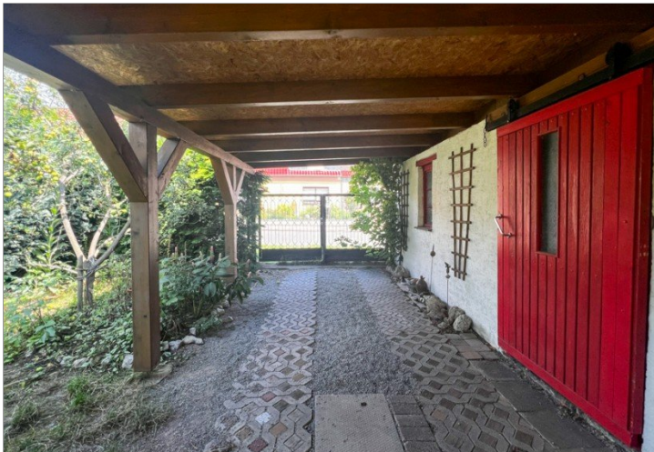
Garport am Grundstücksende
