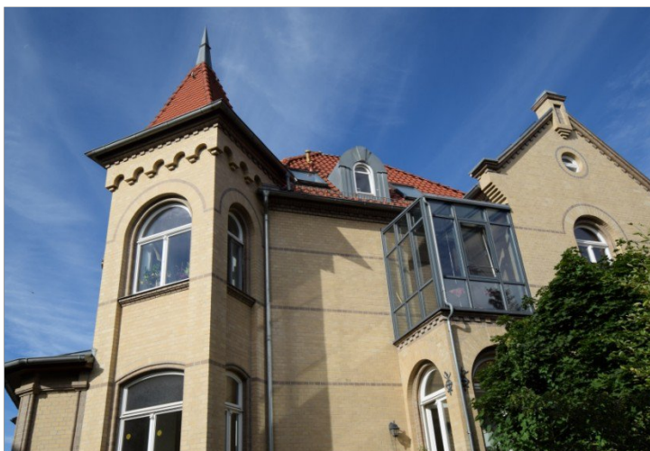
Winzerstraße 12 mit Wintergarten im OG
